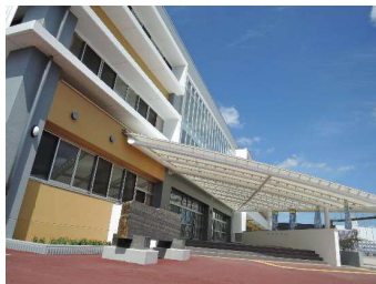
平成30年3月に完成した新校舎
