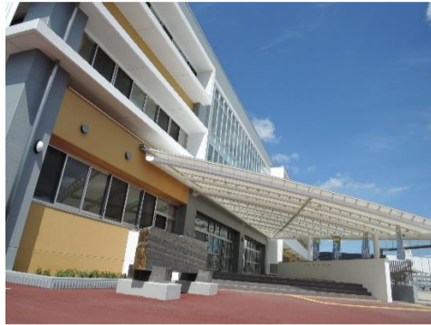
平成30年3月に完成した新校舎
